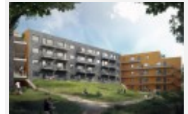
Bild: Wästbygg/Förbo Norra Säteriet i Mölnlycke.
